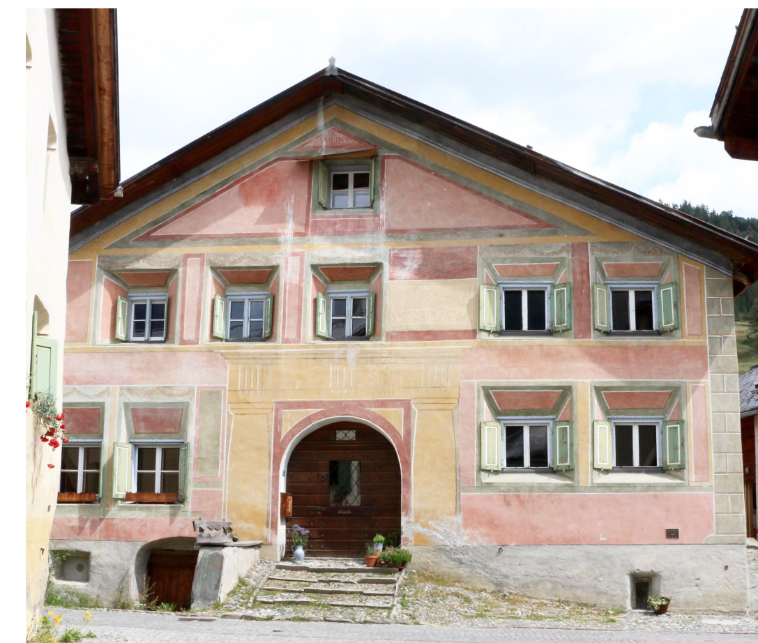
Bild Fassade Süd
